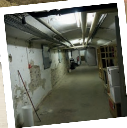
Baustelle im Jahr 2011 Der zukünftige Frühstücksraum ist noch ein Kellergang, die Erdarbeiten für den Eingangsbereich haben begonnen.
